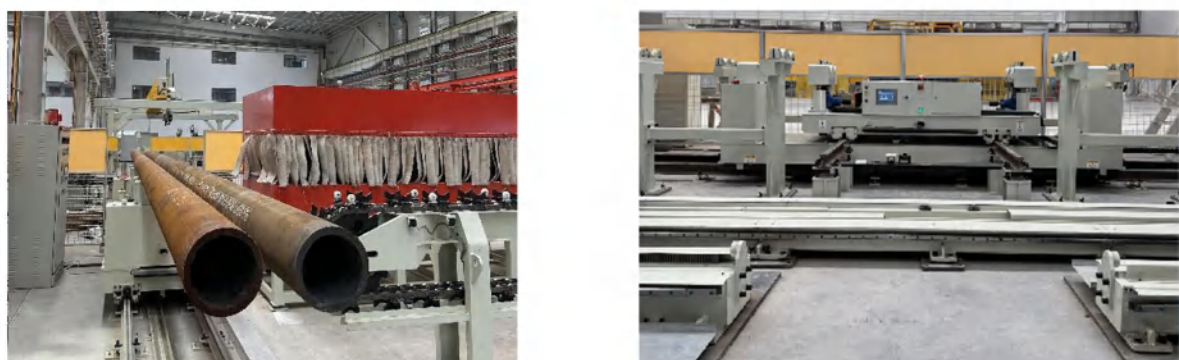
某重型机械厂主弦杆焊接产线RGV
