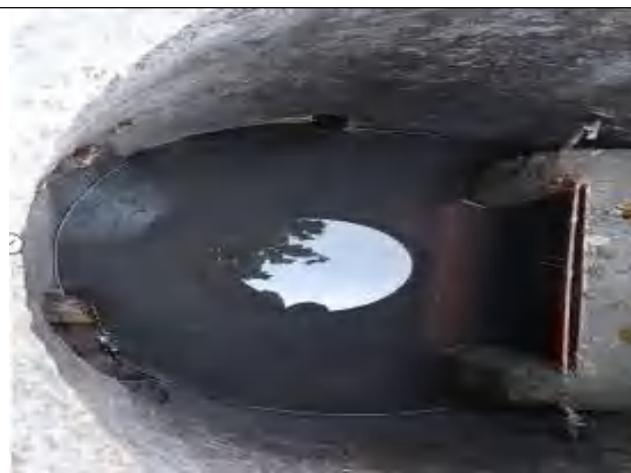
图 2 厂区西侧雨水井应急截止阀
