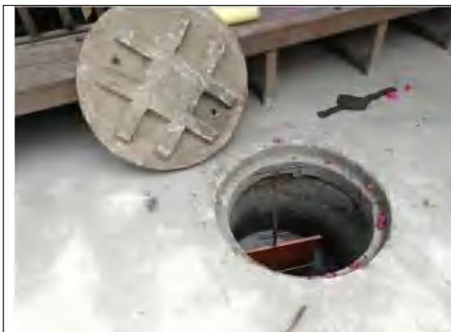
图 1 厂区东北侧雨水井应急截止阀
