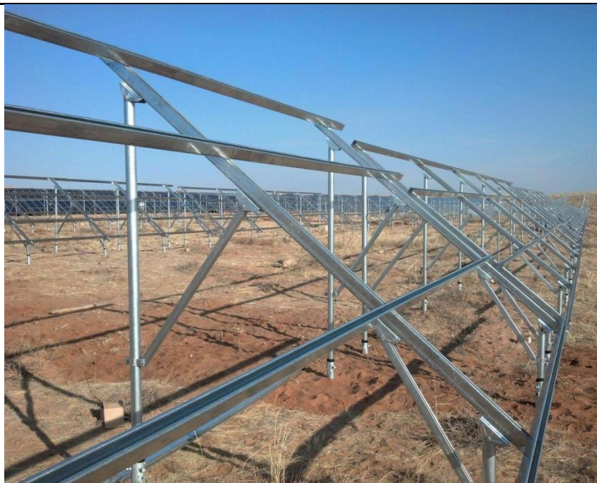
光伏跟踪器的支架结构现状照片
